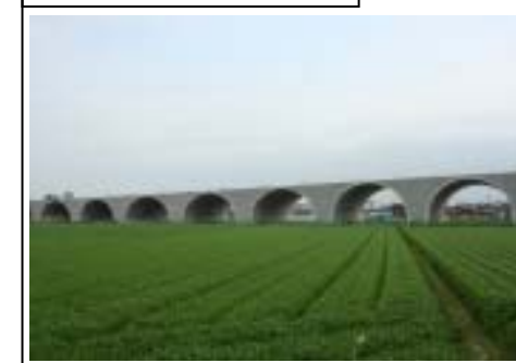
有明沿岸道路施工写真
