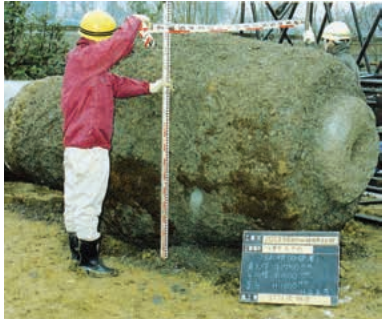
▼杭径1,000mmの球根築造掘出し状況
