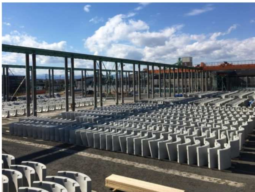
熊谷工場 セグメントヤードの様子
